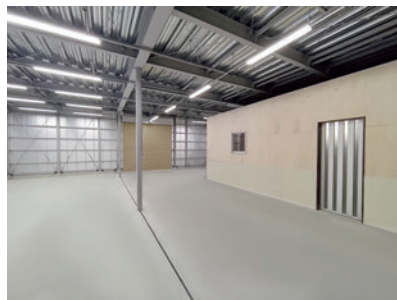
＞建物前後に電動シャッターを設置した倉庫
