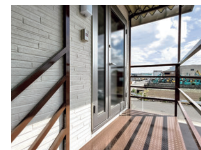
＞外階段から直通の2階事務所入り口
