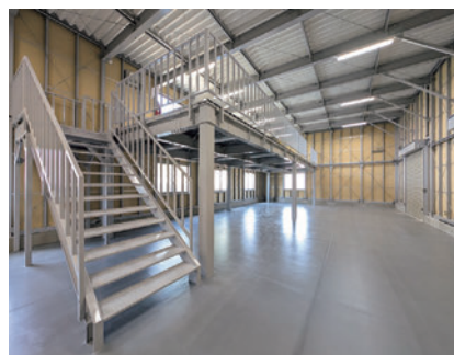
＞重量鉄骨を使用した倉庫内の中2階
