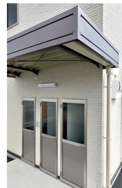
＞土足のまま利用可能なトイレの出入り口
